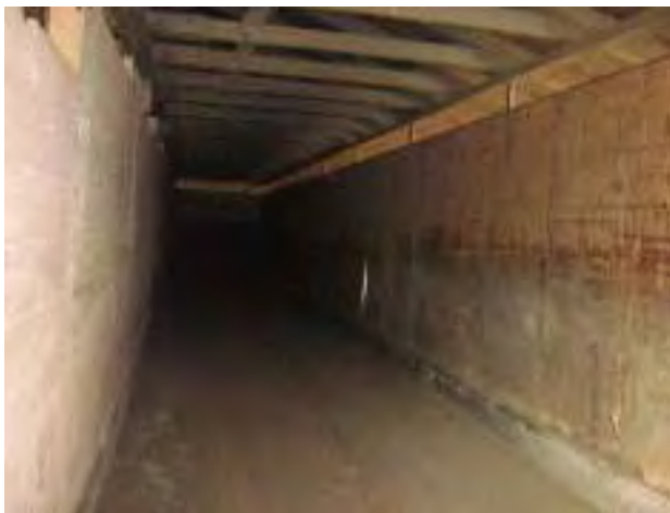
Figura 2.07. Estructura techada donde se almacena la gallinaza para luego ser utilizada en la finca receptora.
